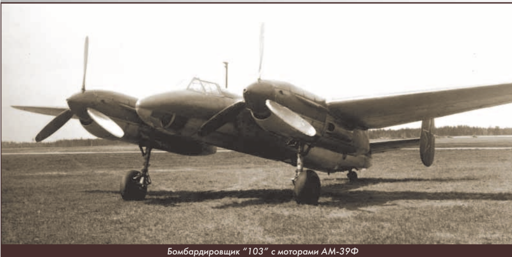
Бомбардировщик "103" с моторами АМ-39Ф
