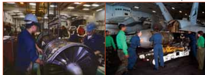
Рисунок 1.61 - а) - ремонтная бригада на борту авианосца Kitty Hawk перед установкой двигателя F404 на истребитель F/A-18. б) - монтаж двигателя
