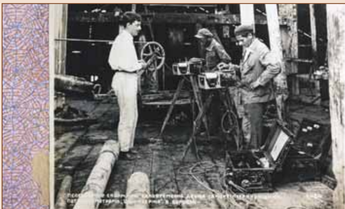
Рис. 7. "Лист № 14 из альбома фотографий "Азнефть XVII-му партсъезду 1934 г.". Исследование скважины двумя саморегистрирующими потенциометрами "Шлюмверге", 1933 г., серебряно-желатиновый отпечаток, 16,4х22,7 см, КП 14290/14
