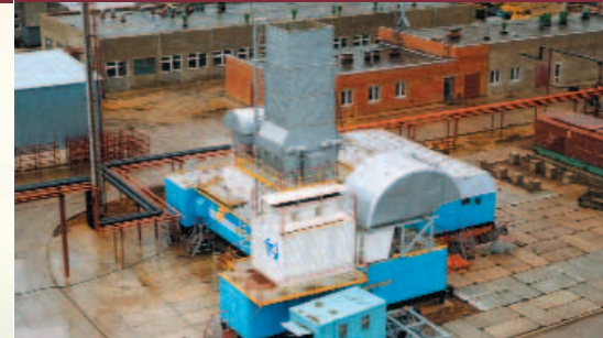
Модернизированный газоперекачивающий агрегат с двигателем UGT 25 000
