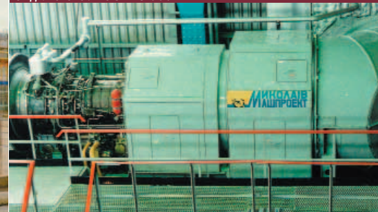
Модернизированный газоперекачивающий агрегат с двигателем UGT 25 000
