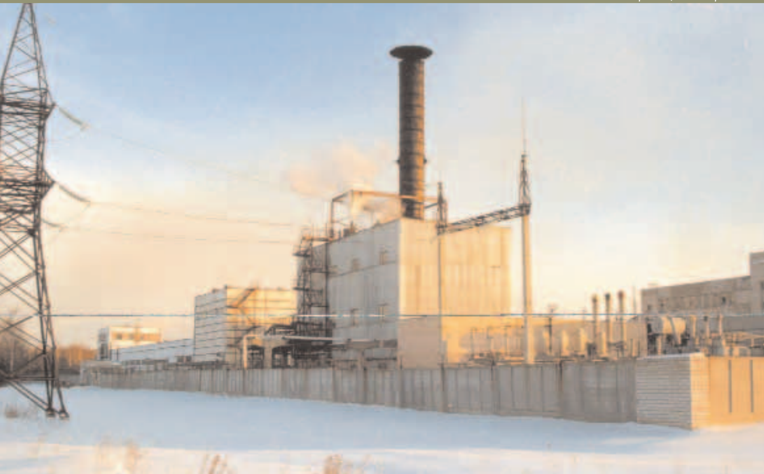
Электростанция в Мозыре
