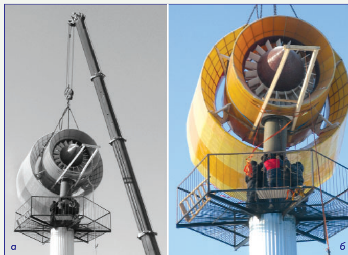
Рис. 9 Монтаж экспериментальной конструкции ЗВТУ компании Arter Technology: а - иллюстрация из монографии Peter Jamieson, б - фотография из архива А.И. Овчинникова
